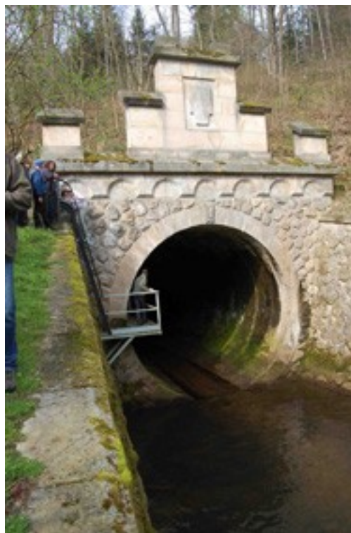
Obtokový tunel z bezpečnostního šachtového přelivu ( \varnothing 5,4 metru)
